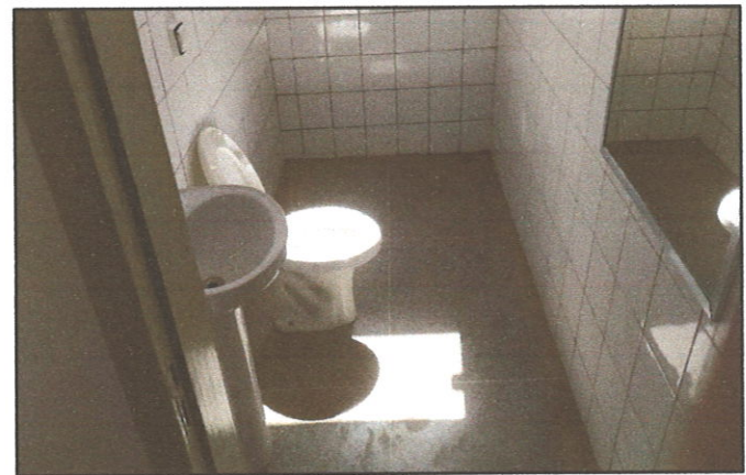
FIGURA 06 - Banheiros sem acessibilidade
